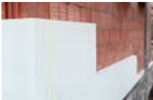
Buitengevelisolatie met afwerkingspleister
