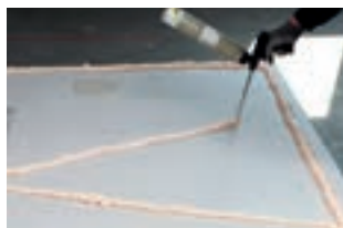
1. Plaat inlijmen met zigzag vormen
