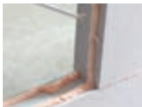
Verlijmen van cellenbeton
