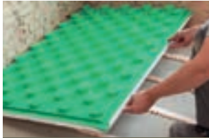
Plaat aanbrengen in de lijm-laag.
