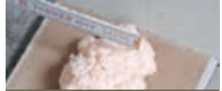
Ø min. 5 cm, max 2 cm oneffenheid uitvlakken
