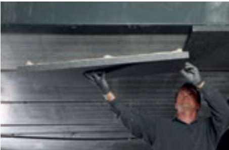
Na ca. 5 min plaat aanbrengen.
