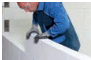
Plaats de steen in de lijmlaag binnen de 9 min.
