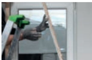
8. Steunbalk plaatsen en zijkant 2
