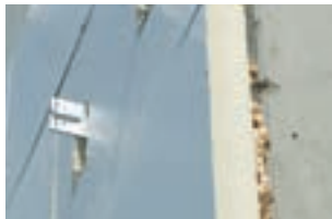
Buitengevelisolatie achter gevelpanelen
