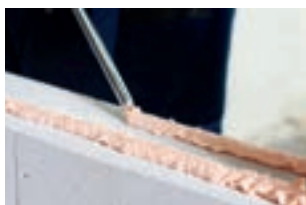
Breng 2 evenwijdige lijmslangen Rectavit Easy Fix aan
