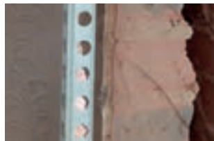
Bevestiging van pleisterprofielen
