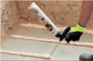
Rectavit Easy Fix aanbrengen op ondergrond.
