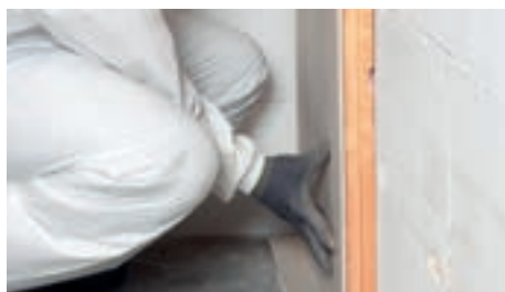
Plaat 1 min. goed aandrukken. Na 1u uitgehard en er kan verder afgewerkt worden indien nodig.
