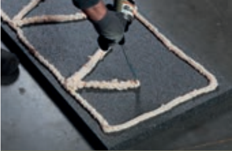
Isolatieplaat inlijmen.
