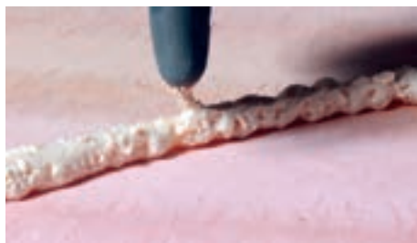
Ca. 5 min wachten tot de lijm voldoende kleefkracht heeft. In deze wachttijd kunnen 6 à 8 platen van 600x1200mm worden ingelijmd.
