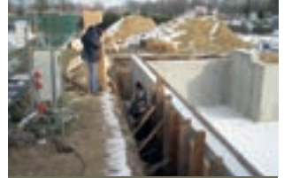
Platen op zijn plaats brengen.
