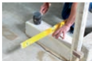
Eerste blok waterpas plaatsen
